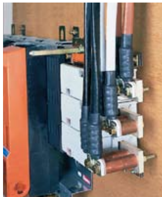
Fig. 2 Cable con. above
